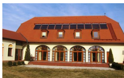
Die Jugendunterkünfte befinden sich auf dem ausgebauten Dachboden des Gemeindehauses
